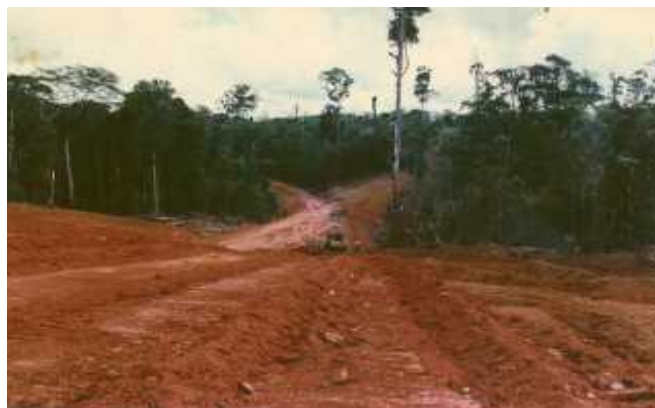
堰を作るため丘より土を運びせき止める
