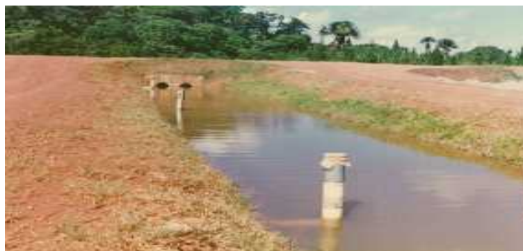
飛び込んだ給水カナル
