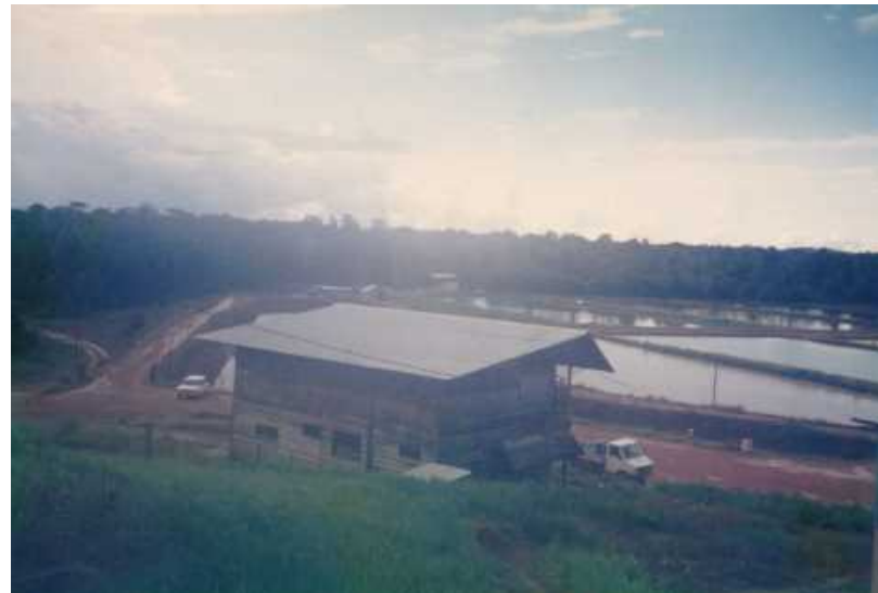
完成後の技術者住宅
