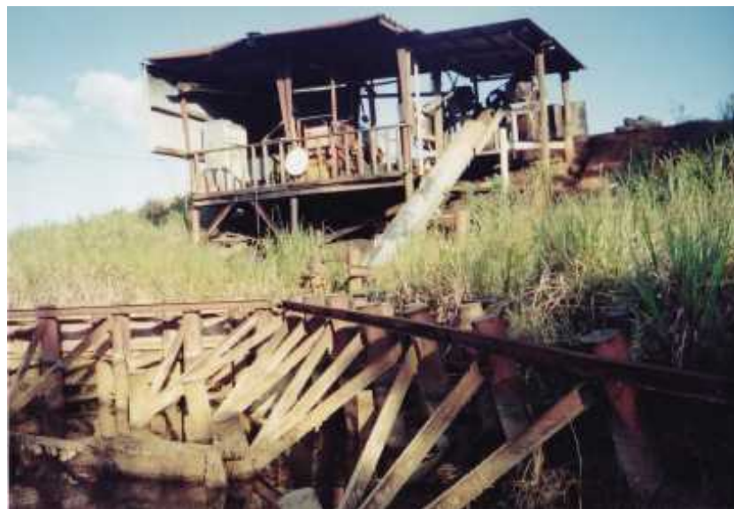
ポンプステーションに据え付けた発電機（左）
